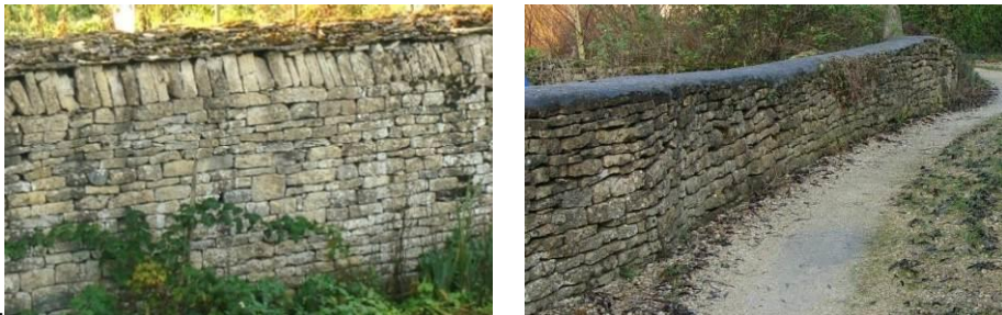
Murs d'assises régulières de pierre calcaire sans joint apparent et couronnement en pierre de lave (gauche) et glacis en mortier (droite)
